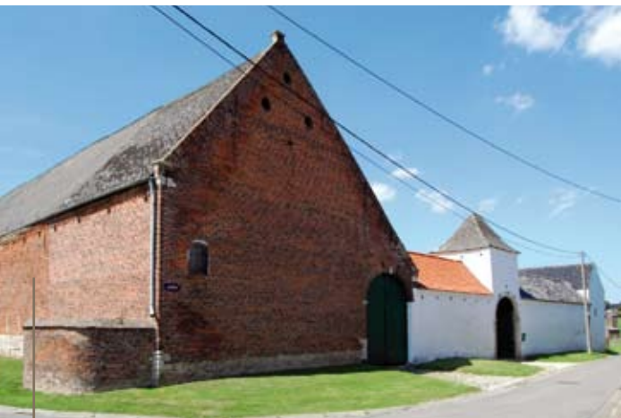
L'accès à cette grange en long se fait par l'extérieur de la cour.
