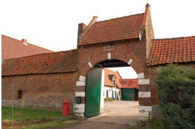
Du rouge pour les briques et les tuiles avec quelques notes claires (badigeon et pierres du porche) et vives (boiseries). Ferme du Paradis à Esquelmes (Pecq).
