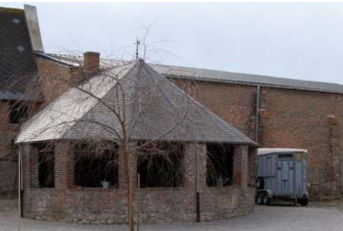
Aire de battage. Ferme à Peissant (Estinnes).
